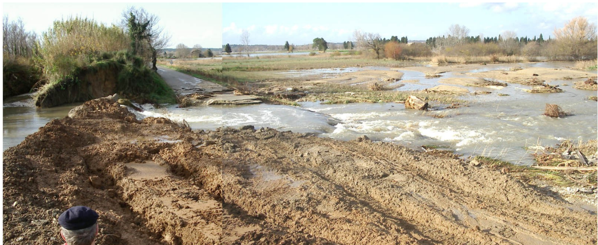
Illustration 11: Crue de l'Auzon à Monteux provoquant une rupture de la digue rive droite, décembre 2008
