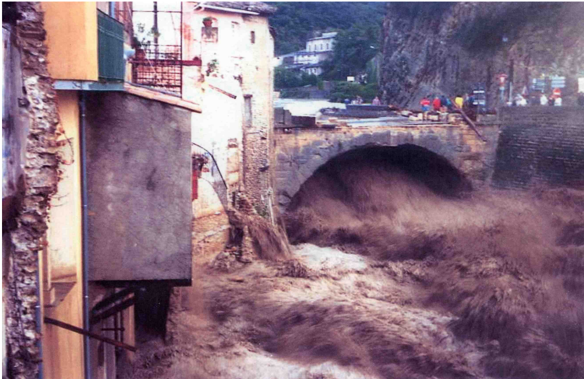
Illustration 7: Crue de l'Ouvèze à Vaison-la-Romaine, septembre 1992 (source : SMOP)
