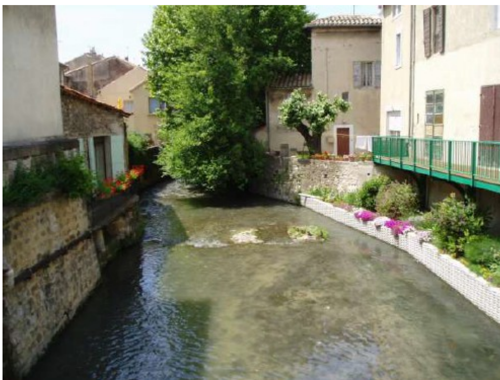
Illustration 4: Vue de la Meyne en secteur Urbain - aval RN 7 Pont de Langes (source ASA/EPA Meyne)
